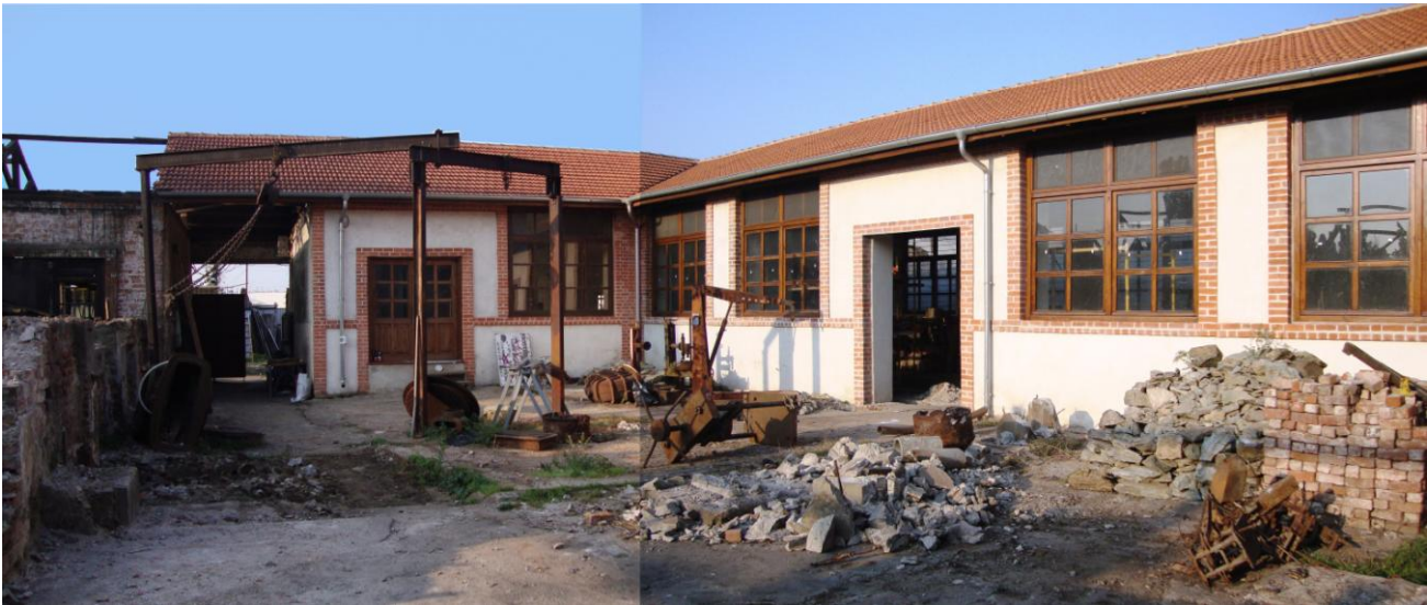
Εικ. 11: Κτίριο Εργαστηρίου της Σχολής Τεχνών και Επαγγελματιών Χαμηδιέ. Αποψη κεντρικού αιθρίου κατά τη διάρκεια των εργασιών αποκατάστασης (φωτ. Κ.Τρακοσοπούλου, 2011)
